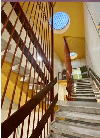
Éclairées par des puits de lumière, les cages d'escalier en « échelle-de-perroquet » semblent en apesanteur.
